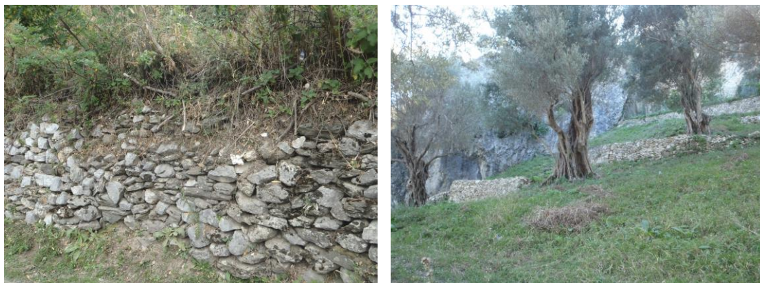
Figura 3. Pamje e një tarrace me gurë të thatë për kontrollin e erozionit
